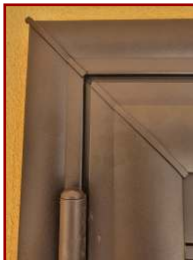
Giunzione anta e telaio
